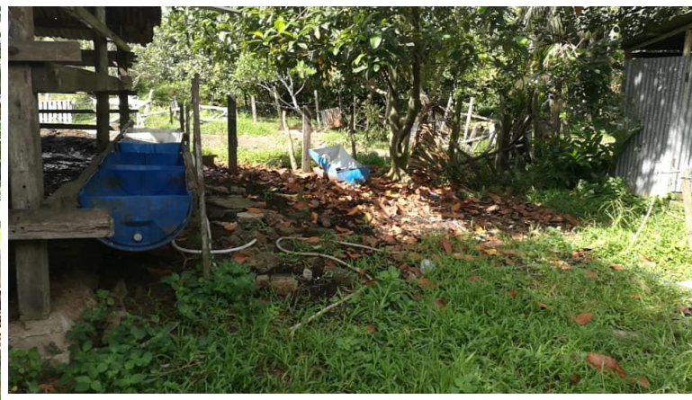
Tapak untuk bina kandang lembu baru. Pemilik kandang perlu membuka dan meruntuh kandang sedia ada dan sediakan tapak untuk bina kandang baru.
